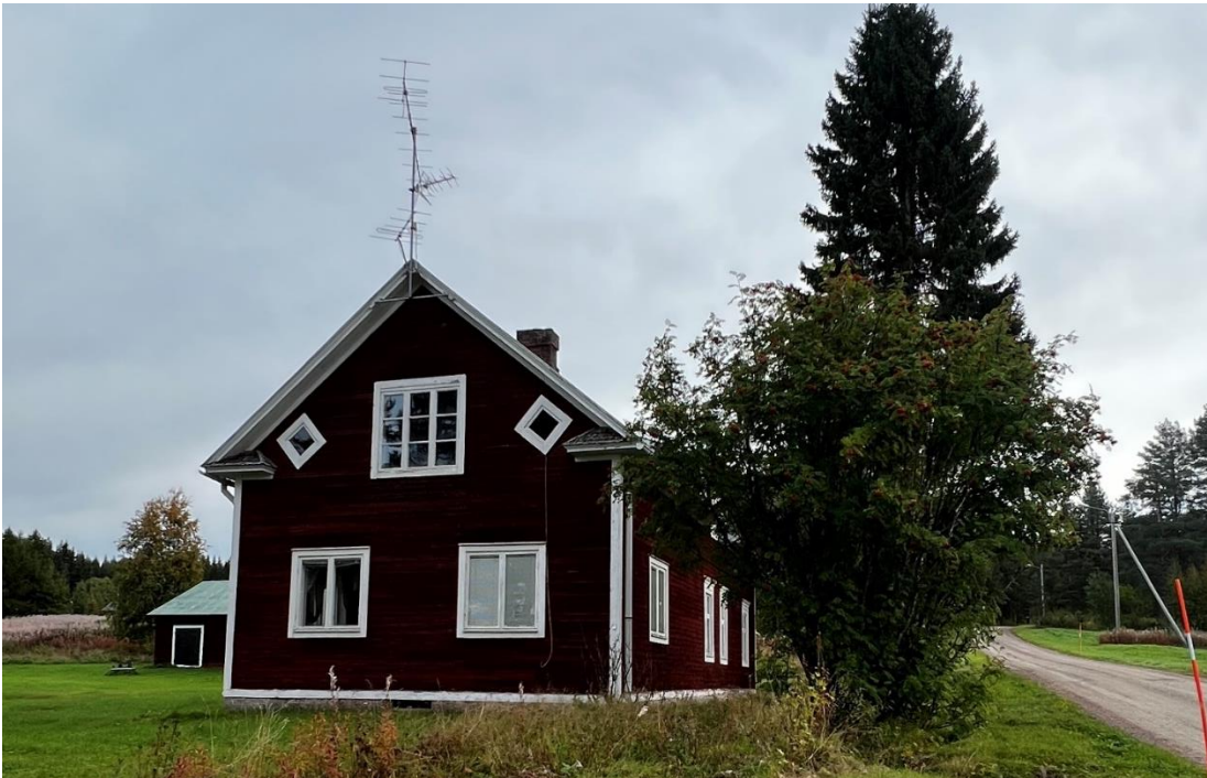
Figur 17. Fotot visar en gammal gårdsmiljö. Intentionerna är att flytta byggnaden i bild till ett nytt läge för att bevara denna.
