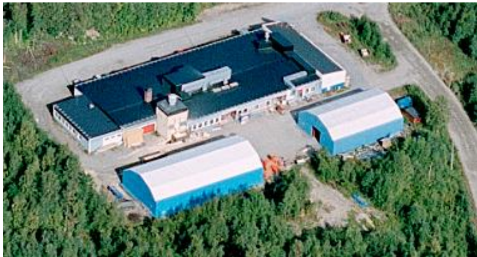
Industribyggnad och två lagertält på fastigheten Korpilombolo 10:132
