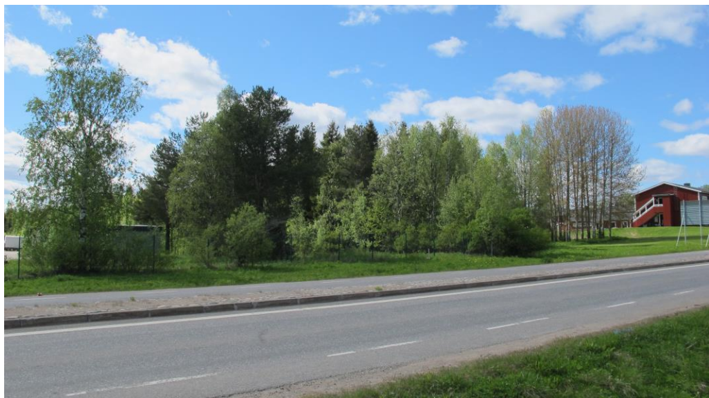
Nätstationen skymtar till vänster i bild och bostadsområde till höger.
