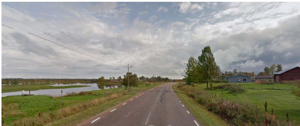
Väg 395 är en barriär mellan bebyggelsen och Torne älv. Bilden visar vägens utseende innan de trafiksäkerhetshöjande åtgärderna. Källa: Google Maps
