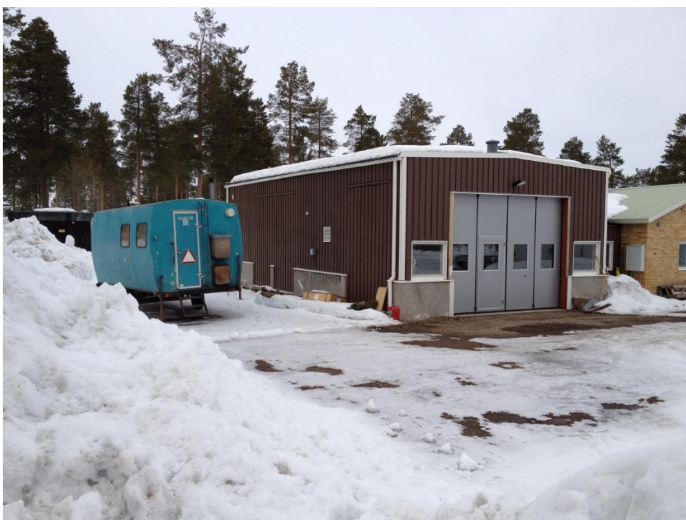
Bilden är tagen mot norr och visar det före detta vattenverket som idag används som garage.
