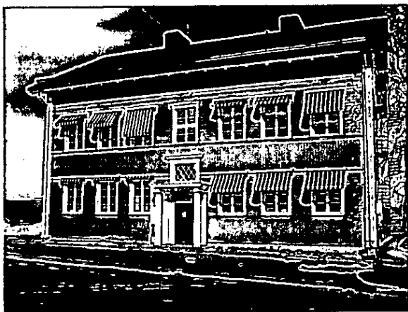
Figur2. Gamla skolans fasad mot Kirunavägen.
