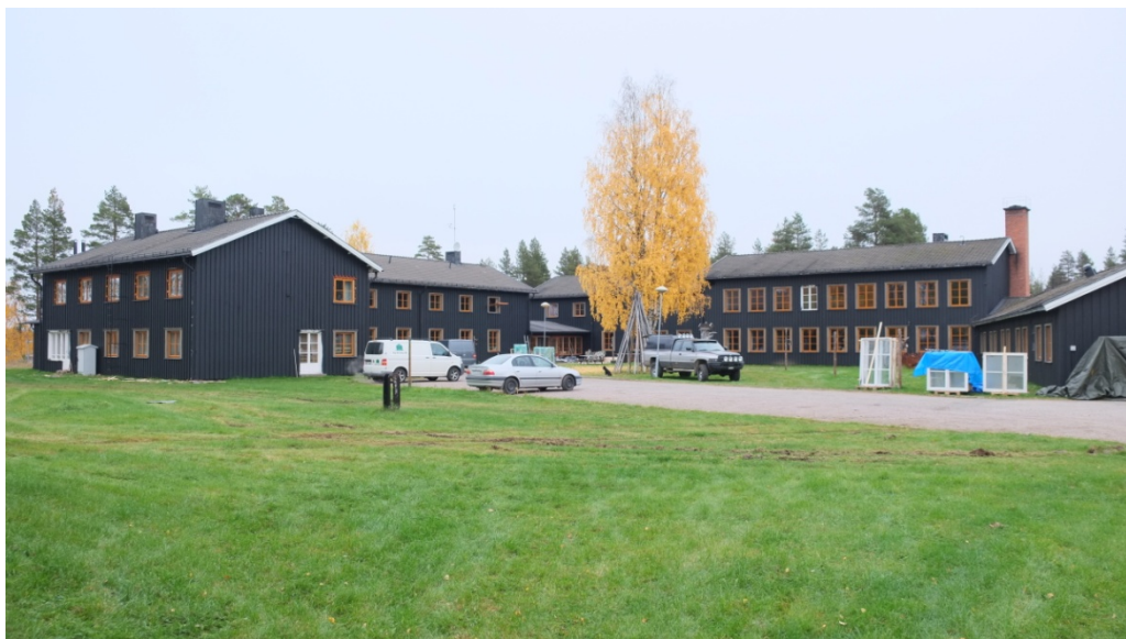
Befintlig hotellbyggnad mot nordost. Foto: Mats Winsa
