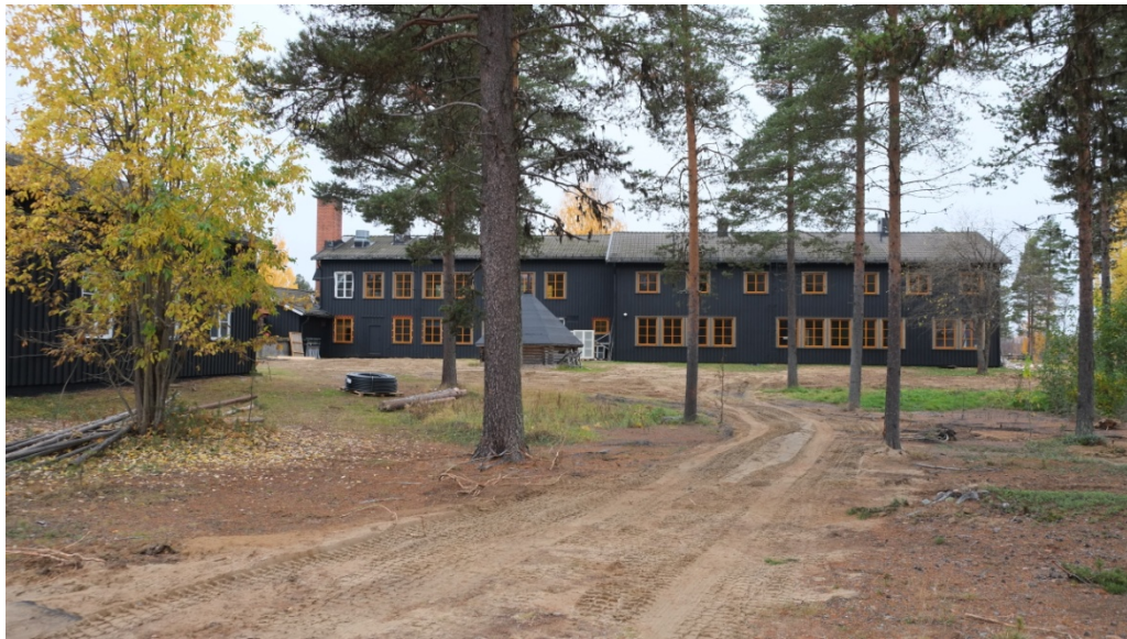
Befintlig hotellbyggnad mot väster. Foto: Mats Winsa
