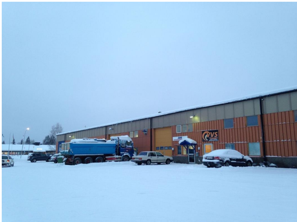
Byggnad i planområdets nordöstra del.
